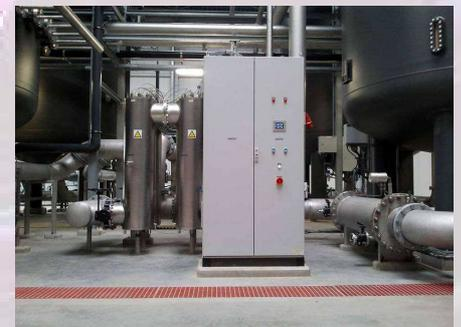
Traitement UV pour le traitement de l'eau à Anvers pour  $Q_{max.} 2 \times 500 \text{ m}^3/\text{h}$
