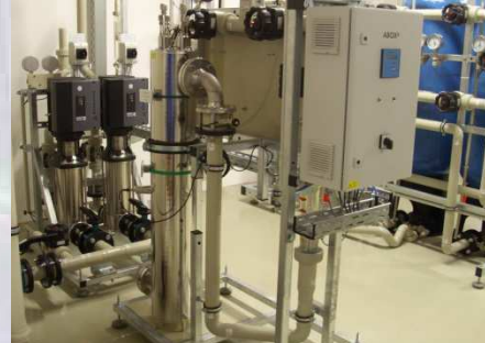
Tratamiento UV para la reducción del TOC
