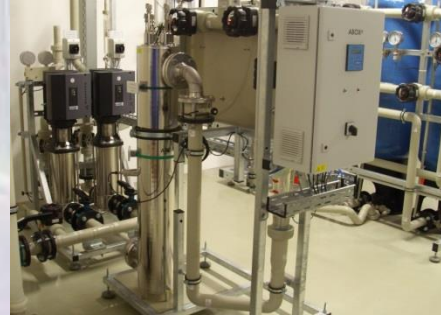
UV Behandlung zur TOC Reduzierung
