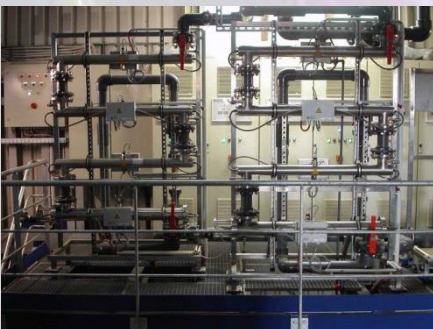
UV Behandlung für die Wasseraufbereitung zur CSB Reduzierung im Hamburger Dock
