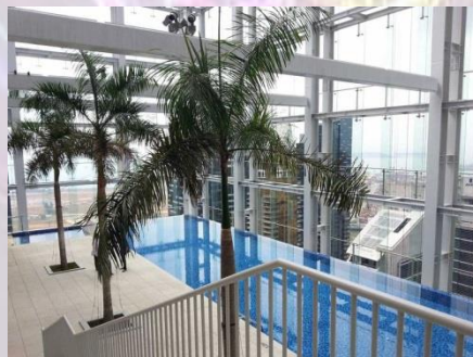
UV Behandlung für öffentliches Schwimmbadwasser, im 37. Stock in Singapur mit Blick auf die Skyline und Hafen
