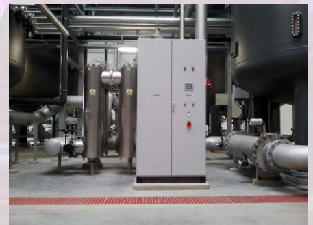
UV Behandlung zur Wasseraufbereitung in Antwerpen für Q_{\max.} 2 \times 500 \text{ m}^3/\text{h}
